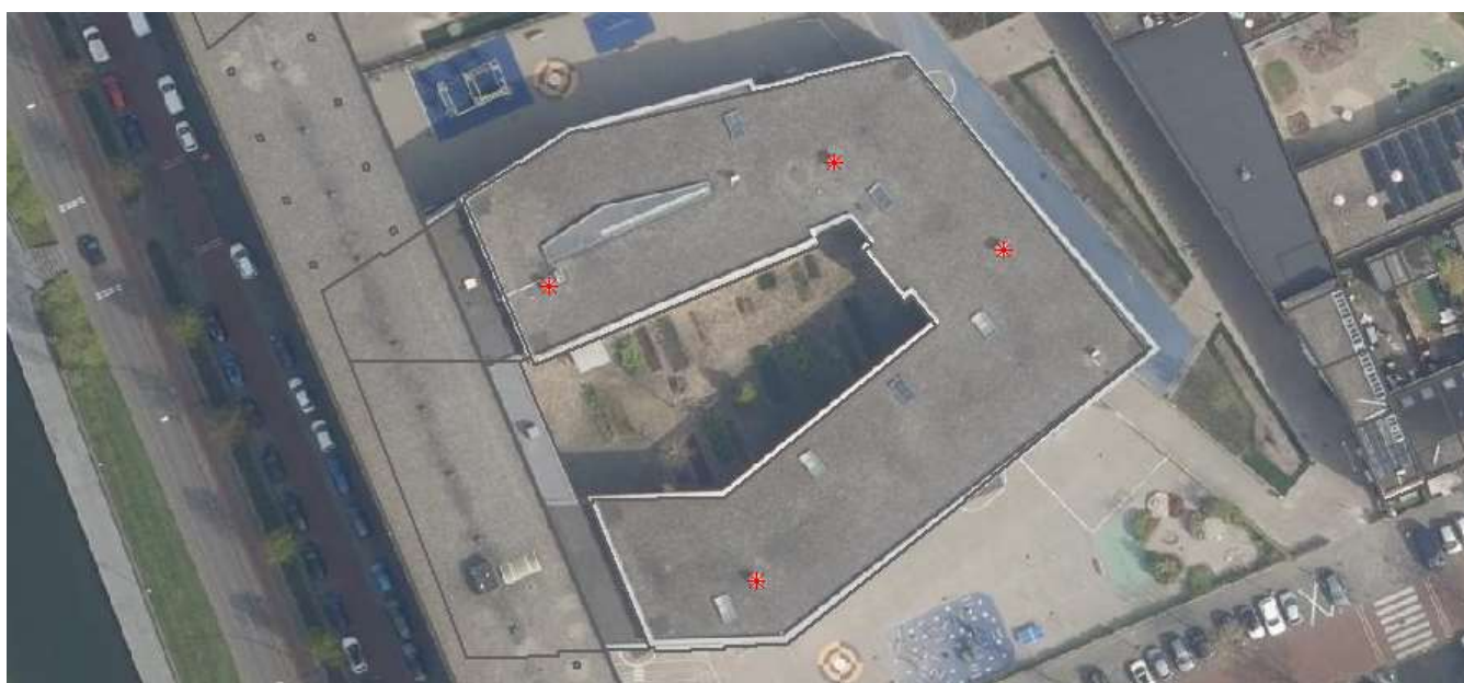
Figuur 1.1 Ligging van de dakventilatoren
